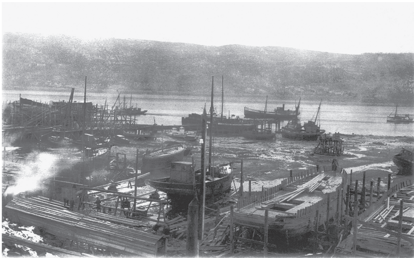
Верфь деревянного судостроения
